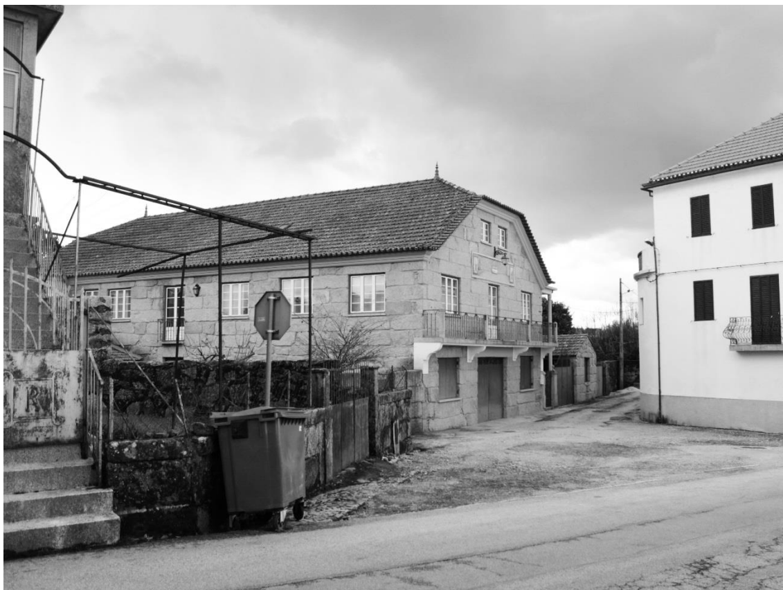
Figura 11 – Antigo armazém, inserido no núcleo urbano
