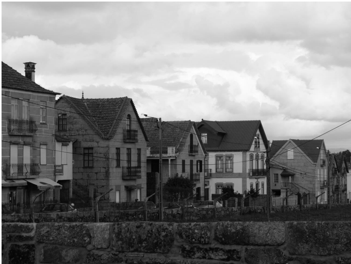
Figura 14 – Casas da rua principal de Vila Verde, onde figuram três exemplares de cobertura de oito águas
