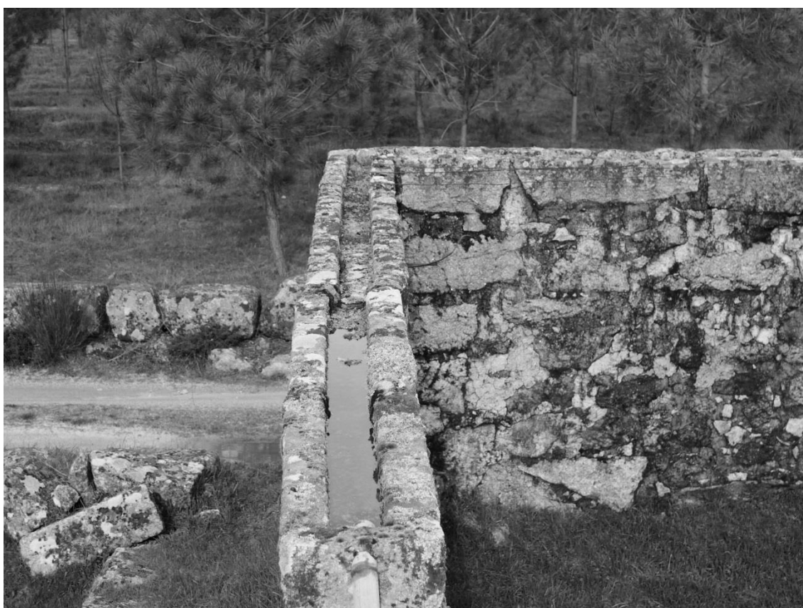
Figura 8 – Sistema de transporte de água, necessária para a lavagem das peles
