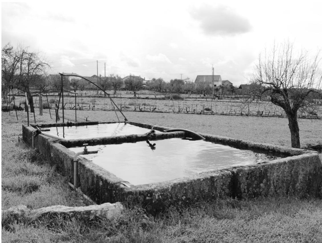
Figura 3 - Exemplo de tanque usado nos processos tradicionais de curtimenta das peles
